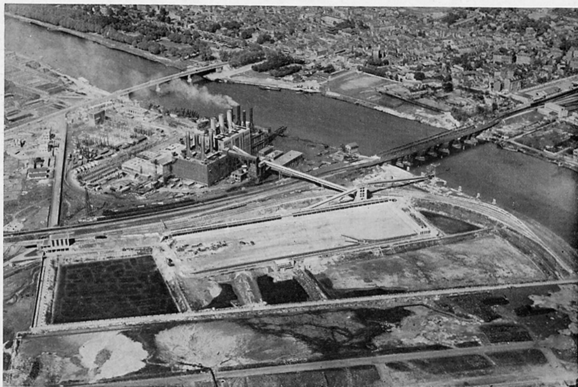
Fig. 1. — Vue aérienne de l'usine de Gennevilliers pendant la construction.
